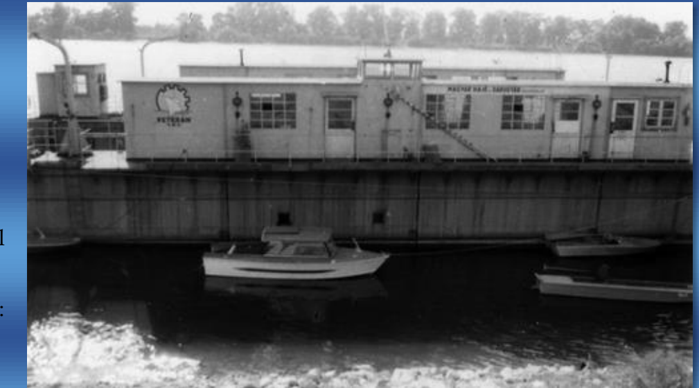
Az úszódokkból alakított vízparti szerelőműhely
